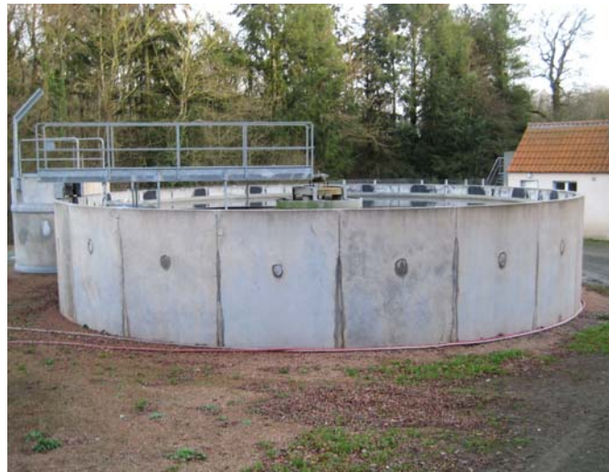
Clarificateur de la station d'épuration de Bournezeau
